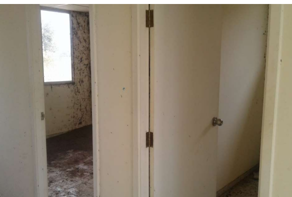
Vista interior de las viviendas
