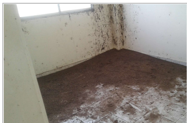
Vista interior de las viviendas
