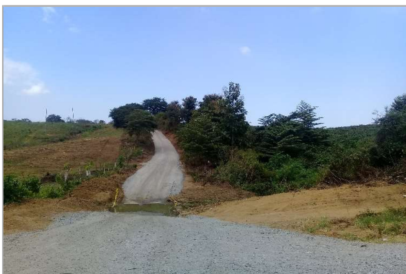
Vista de vía de acceso
