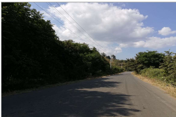
Vista de vía de acceso
