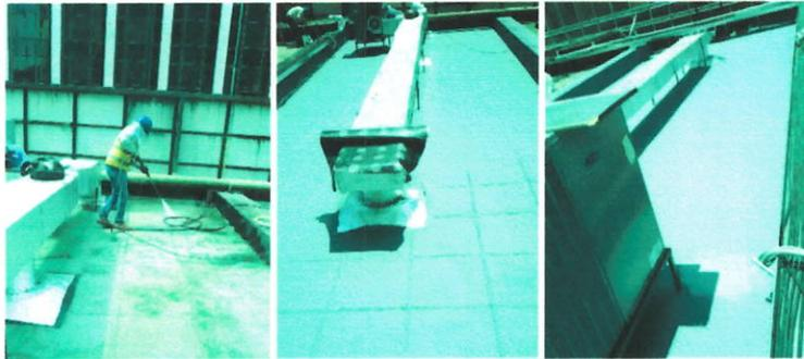
**INSTALACIÓN DE EQUIPOS Y DUCTOS DE CLIMATIZACIÓN.** \_ Se instalaron de equipos nuevos y sistemas convectos a estos, incluyendo soportes, ductos de climatización, tableros eléctricos, canalizaciones eléctricas, cableado y conexiones eléctricas de fuerza y control establecidas según planos de montaje.
