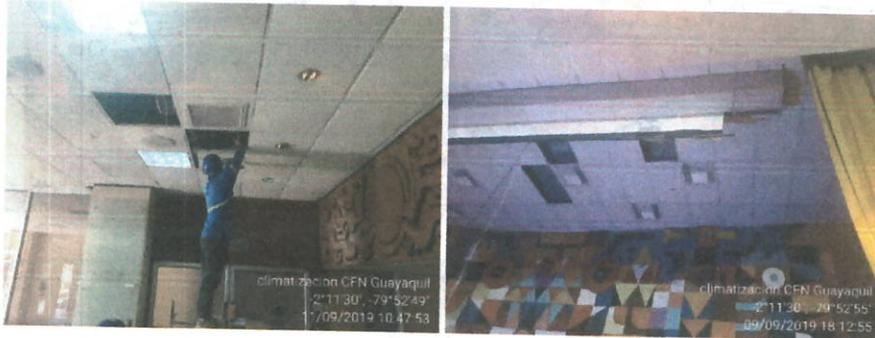
**RESANE DE LAS SUPERFICIES.** \_ Se realizó el debido resane con la precaución de que no quede ningún orificio descubierto en cada uno de los paños de la loza superior del salón del auditorio y salón multifuncional donde los equipos estaban asentados.
