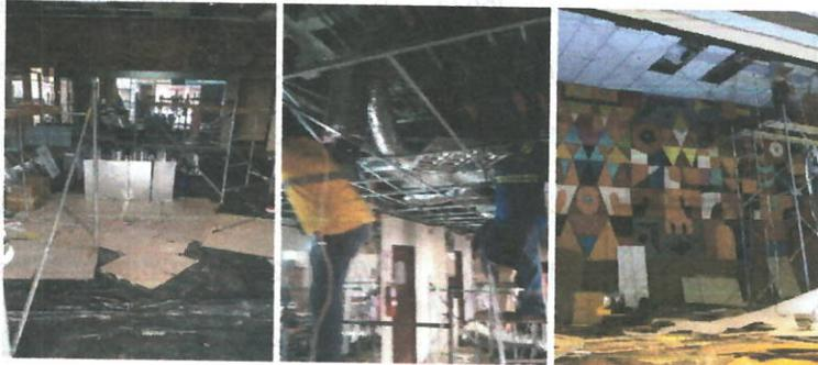
**DESMONTAJE DE EQUIPOS.** \_ Se desalojó todos los equipos y ductos viejos de las dos losas. Se removieron en su totalidad y se entregaron mediante reporte a Bodeguero para evidenciar el contenido.
