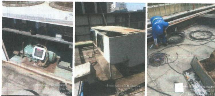
**INSTALACIÓN DE EQUIPOS Y DUCTOS DE CLIMATIZACIÓN.** \_ Se instalaron de equipos nuevos y sistemas convexos a estos, incluyendo soportes, ductos de climatización, tableros eléctricos, canalizaciones eléctricas, cableado y conexiones eléctricas de fuerza y control establecidas según planos de montaje.
