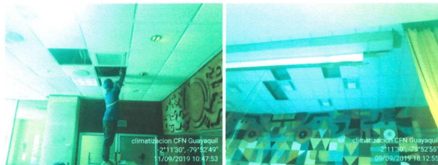
CONEXIÓN ELÉCTRICA. \_ Se instaló debidamente el cable calibre 2 (AWG) para la acometida y el cable calibre 3x6 AWG y 3x4 AWG para la alimentación de los equipos; Se realizó el arranque y prueba de equipos con su respectivo voltaje y amperaje.
