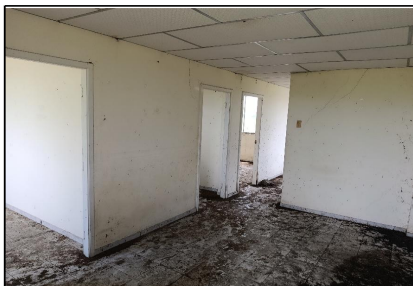
Vista interna de viviendas tipo
