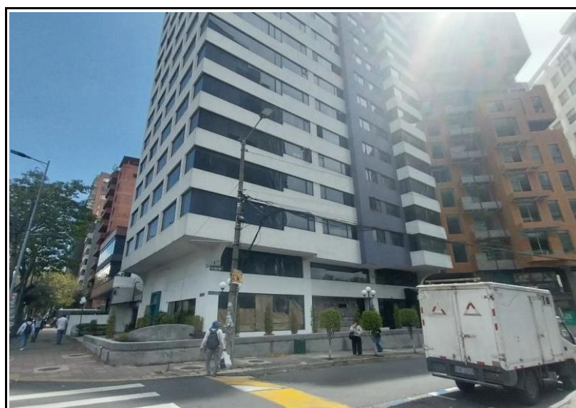
Fachada de la edificación
