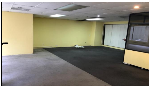
Vista General del inmueble
